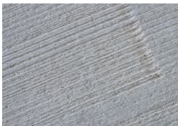
Oberfläche gefräst
